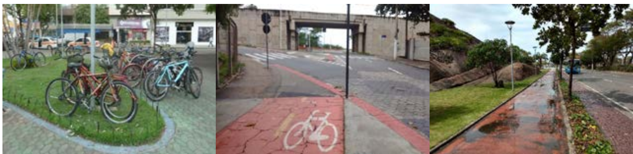
Figura 17: À esquerda, exemplo de poucos estacionamentos para bicicletas: ao centro, pavimentação inadequada com descontinuidade da via; e à direita, drenagem ineficiente.
