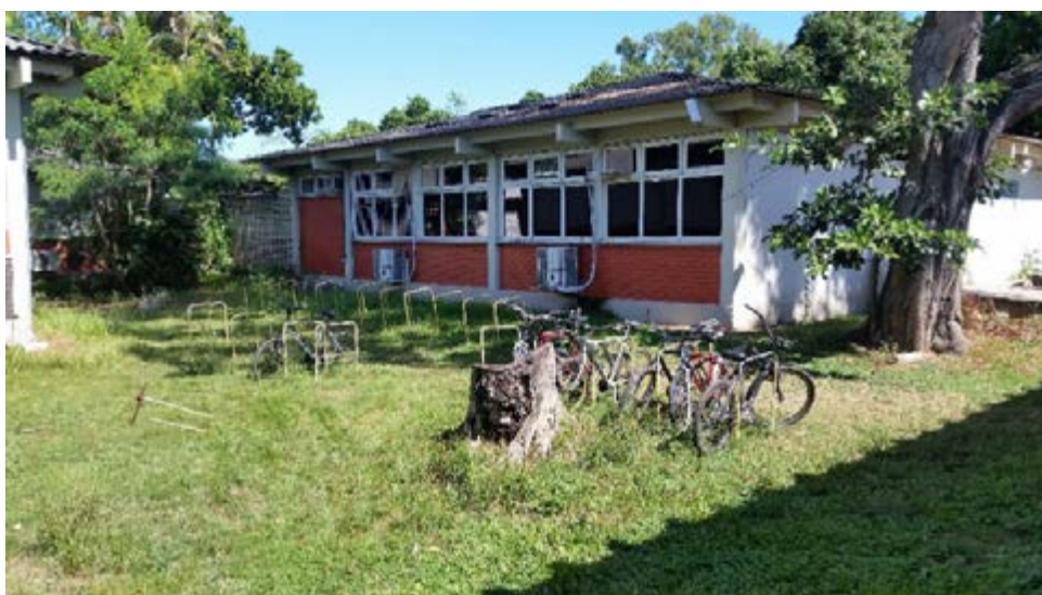
Figura 5: Paraciclos em estado de conservação , com a fixação comprometida.
