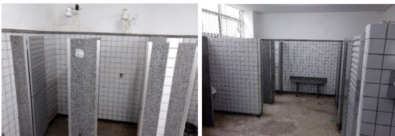
Figura 13: Vestiários no CEFD, com chuveiros e bancos.
